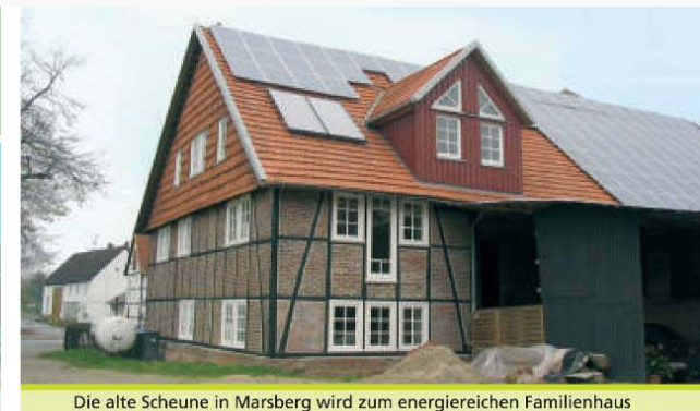
Die alte Scheune in Marsberg wird zum energiereichen Familienhaus
